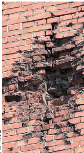
Wieża wymaga szybkiego remontu
